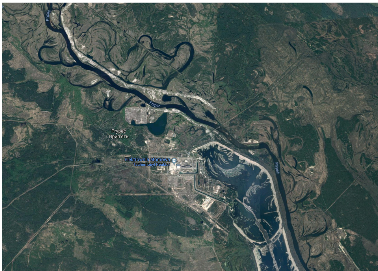
Рисунок 2. Расположение реки Припять, огибающей Чернобыльскую атомную электростанцию в зоне отчуждения ЧАЭС (ортофотоснимок: Google)
