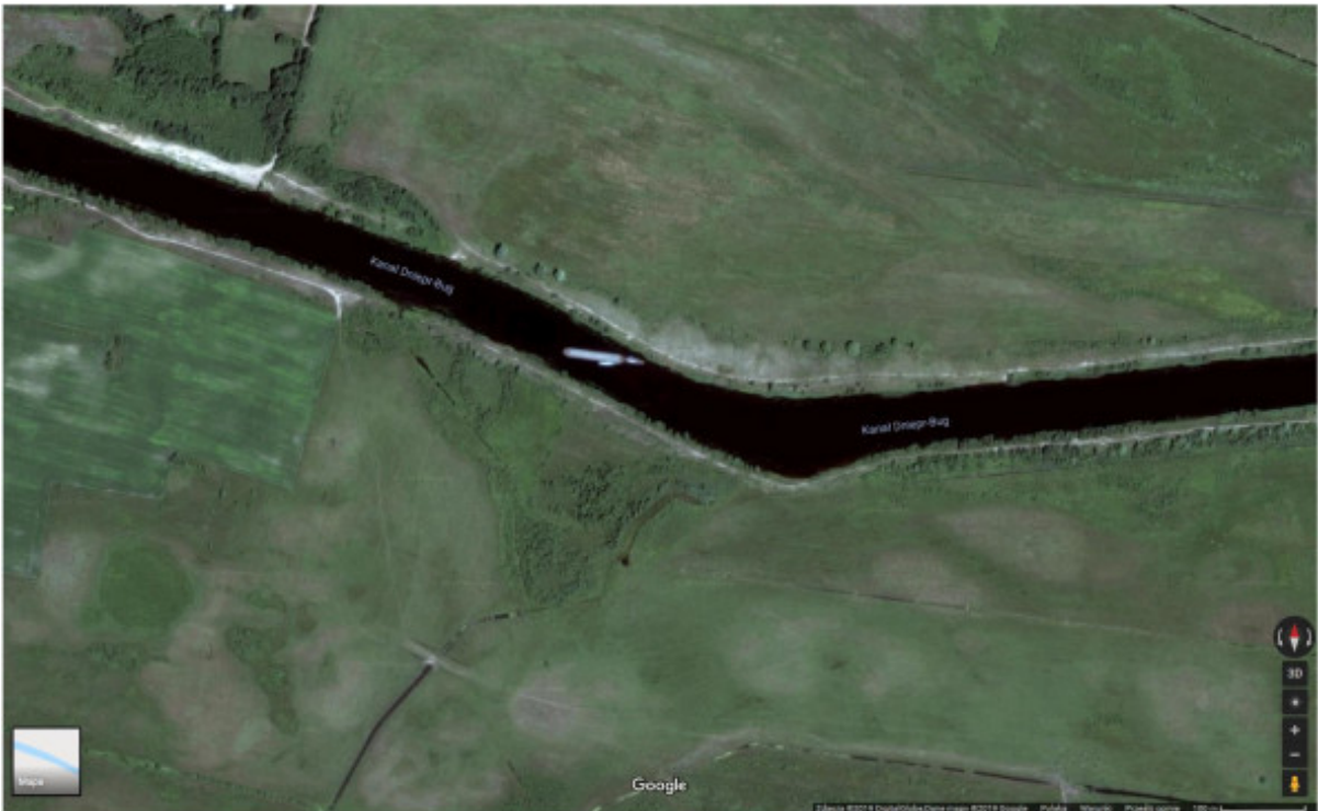
Рис. 3.6. Внутреннее судоходство по запланированному участку ВВП Е40 – +/- 100-метровое судно на Днепроовско-Бугском канале. Ортофотоснимок: Google
